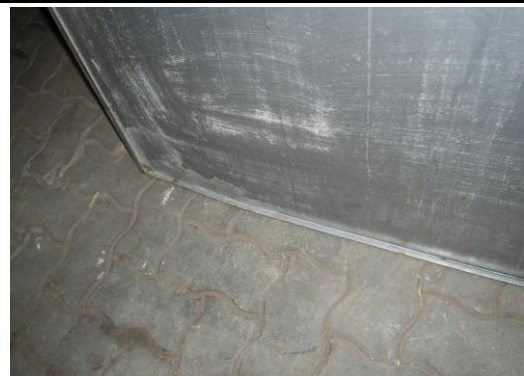
Deckel unten verformt
