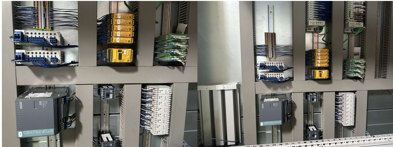
Pilz PNOZmulti Sicherheitsrelais (15K3, 17K2, 17K5, 17K7, 18K1, 18K5)
