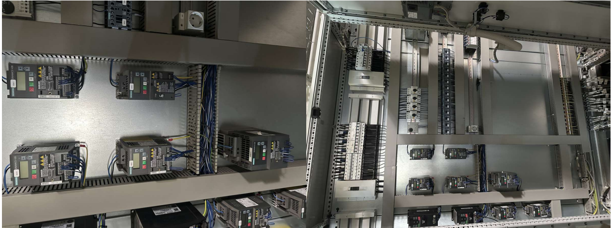
Schaltschrankfeld mit Hitachi SJ1 und Siemens SINAMICS V20 Umrichtern
