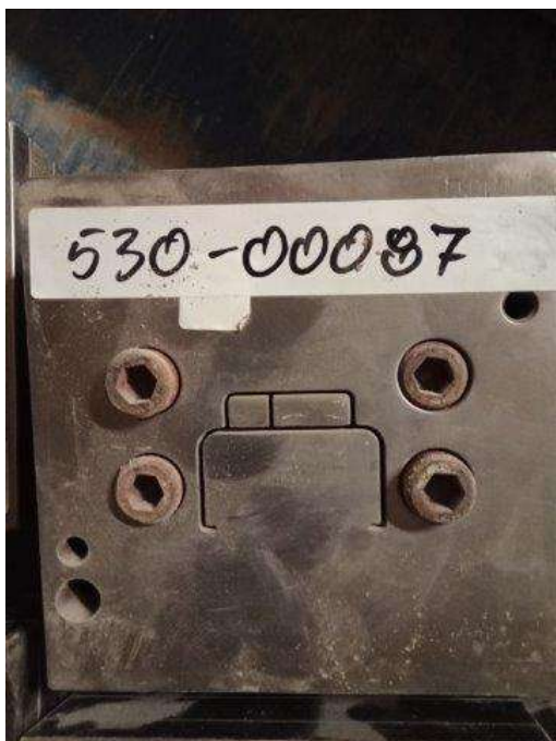
Kanał elektr do RBS
