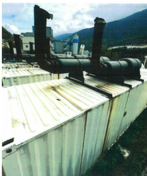
Photo II Vue des échappements
