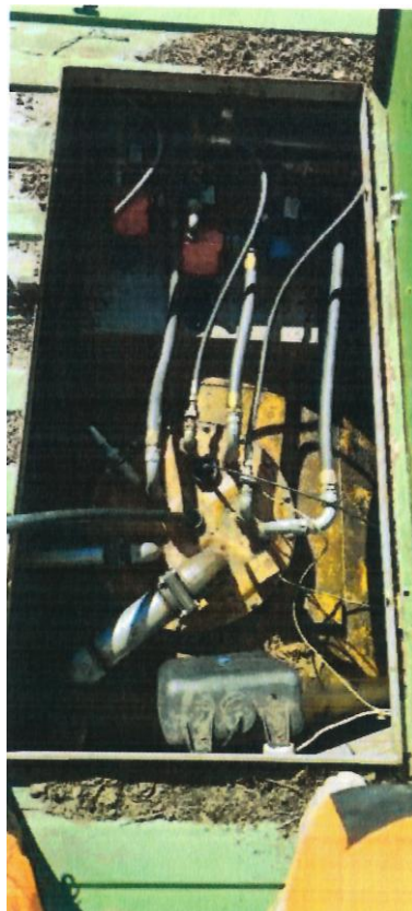
Photo XI La pompe de distribution du Gas oil
