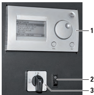
Bedienelemente KWB Powerfire
