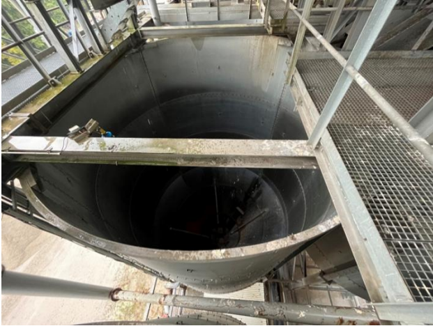
Abbildung 10 Silo von oben (Mittel- und Grobsandsilo)
