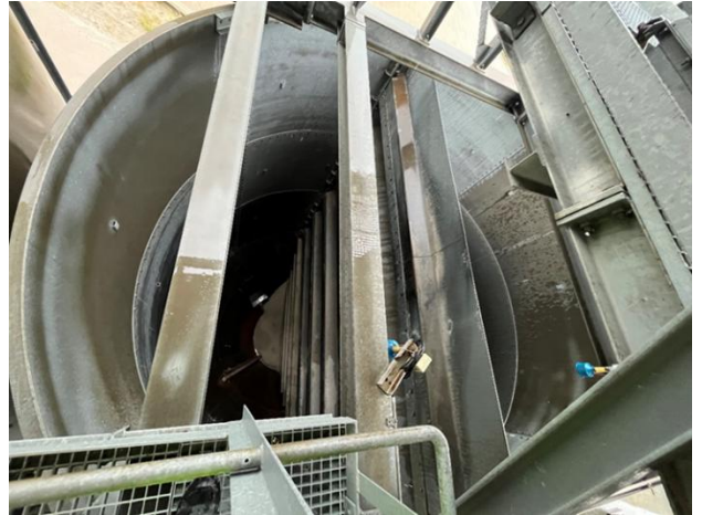
Abbildung 9 Trennwand in Feinsandsilos
