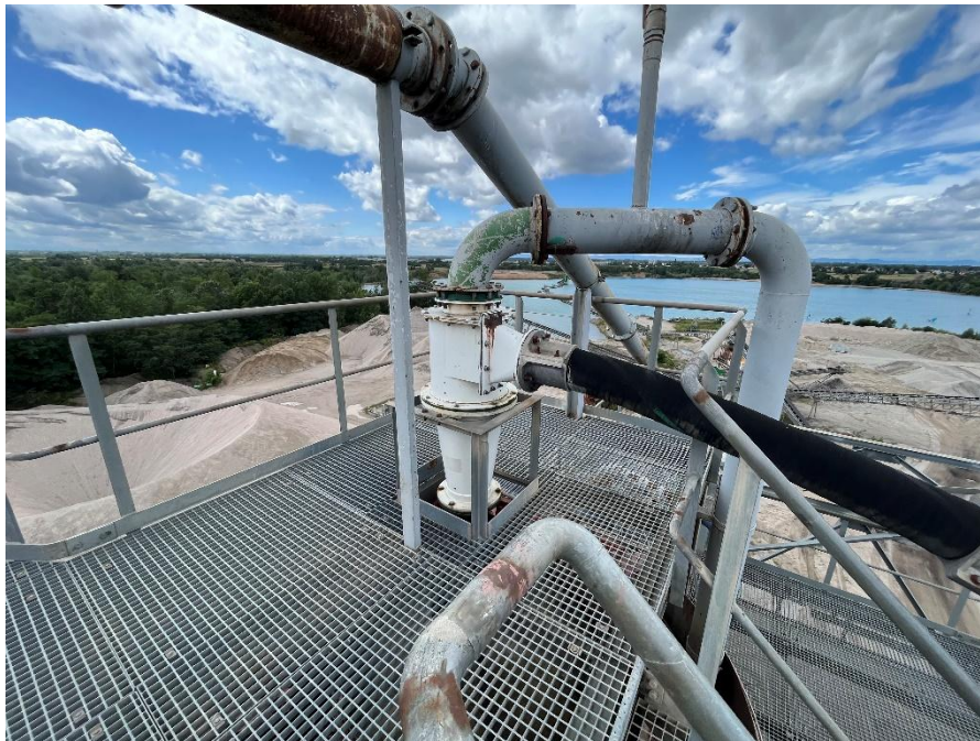
Abbildung 6 Hydrozyklon PC 420-15-0
