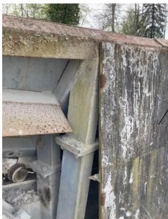
Fig. VIII Vue tôle de protection de l'ATM contre les chutes de matériau au déversement du godet
