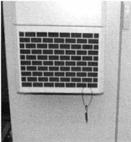
Abbildung 8-11 Lüfter im Schaltschrank
