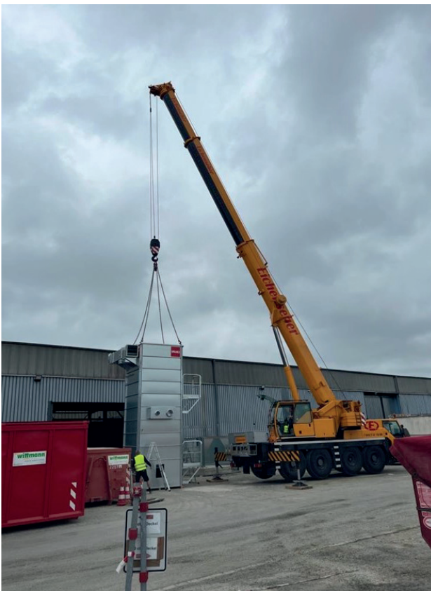
Abbildung 1 (L): Einbringung des Filters per Schwerlastkran über das Hallendach.
