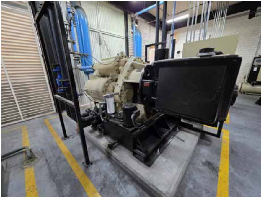
Lote 153: Sistema de enfriamiento de aceite para compresor Incluye intercambiador de calor Marca GIRESA, Modelo GHTS-442
