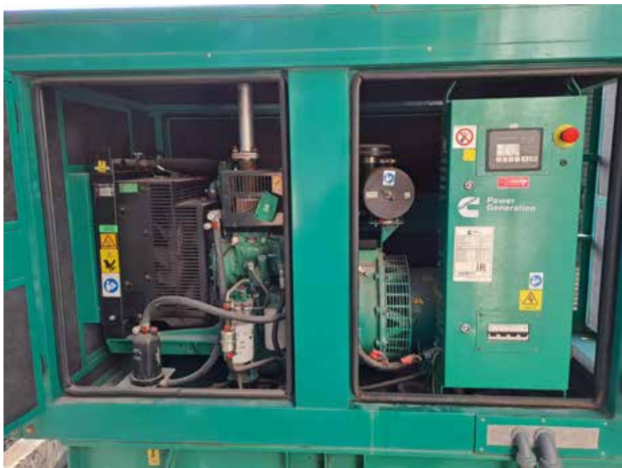
Lote 31: Planta de luz de 25/20 KVA /KW Marca CUMMINS, Modelo C20D6, Serie D21I1150171, Año 2021, Voltaje 220 V, 60 Hz, 1317 hrs de uso, Hecha en India.
