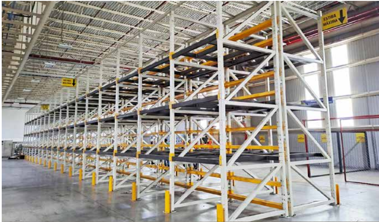
Lote 285: Lote de Rack Industrial con estructura fija en PTR 4X3", contiene 19 verticales de 5.15 x 1.80 mts aprox, 144 Horizontales de 1.86 mts aprox, 54 porta tarimas de PTR 4X2"
