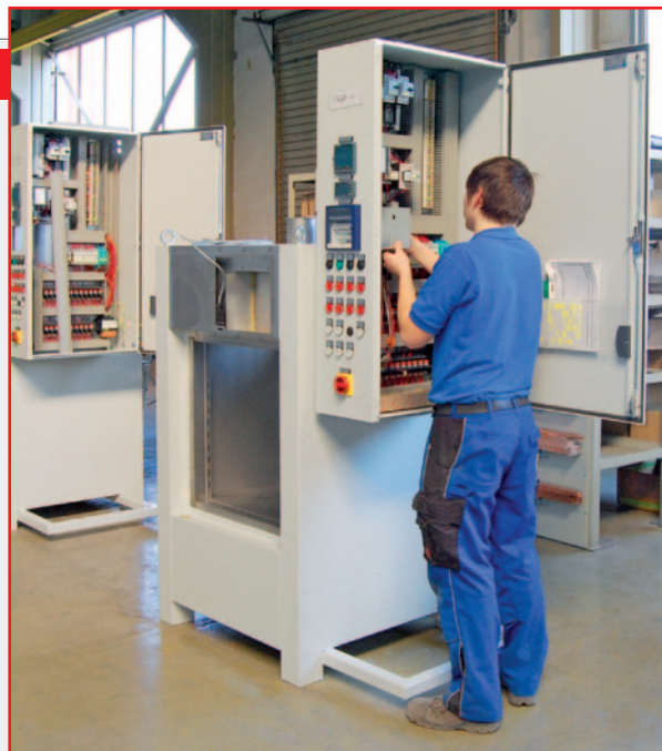
Installation der Elektroanlagen
