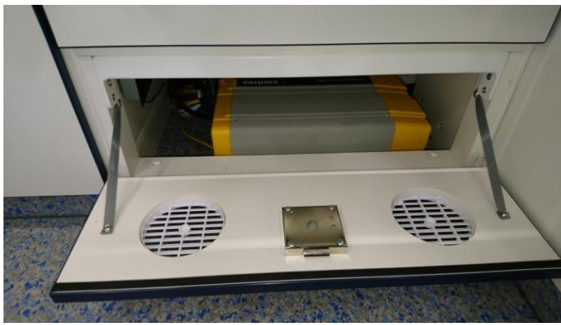
Der Ein- und Ausschalter befindet sich links neben dem Wechselrichter und sollte dauerhaft eingeschaltet sein.
