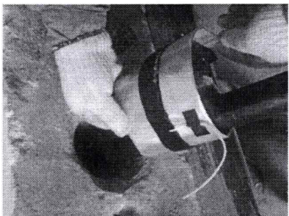
SCHRITT 4 ADE UM DAS KABEL WICKELN. FÜLLSCHLAUCH AUF DER AUSSENSEITE POSITIONIEREN.
