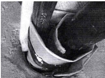
SCHRITT 5 RICHTIG! FÜR 2 KABEL, ADE UM BEIDE KABEL WICKELN!
