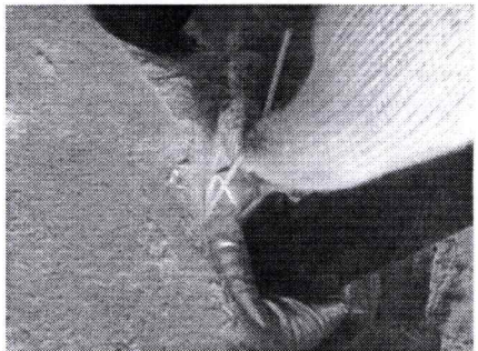
SCHRITT 8 STABILEN DRUCK ABWARTEN UND FÜLLSCHLAUCH ABZIEHEN.
