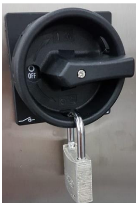
Figuur 1.4 Hoofdschakelaar vergrendeld in de O-/ Uit positie.
