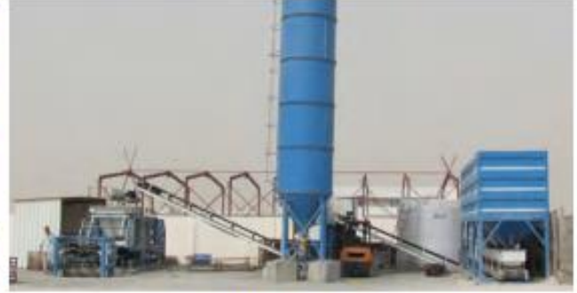
Katar - ZIM 1025 I Tipi Beton Parke ve Blok Üretim Tesisi Qatar - ZIM 1025 I Type Concrete Pavers and Block Production Facility
