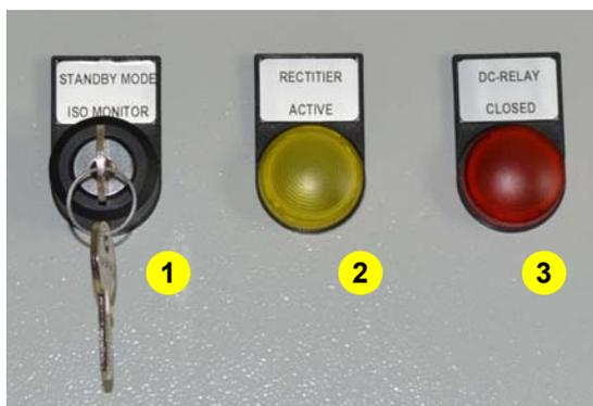
Abb. 7 Standard: Schlüsselschalter und Signalleuchten
