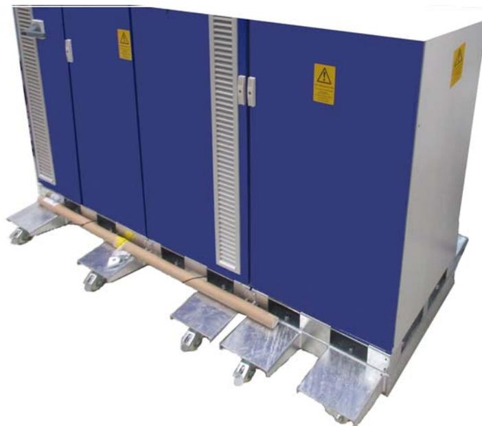
Abb. 21 Beispiel: Schranksockel mit Transportrollen und Sicherheitsaufkleber
