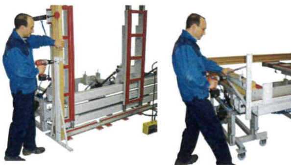
Montage der Schraub und Stützbeinen
