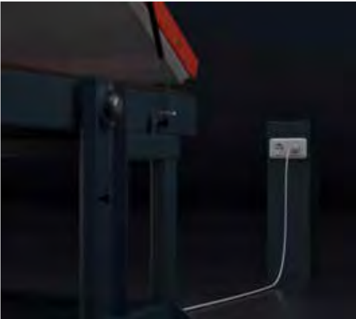
230 V Energieversorgung 230 V power supply
