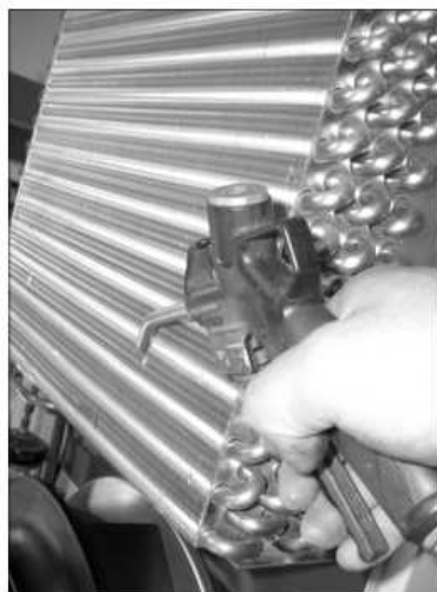
Abb. 55: Wärmetauscher und Kompressorraum mit Druckluft ausblasen (1)
