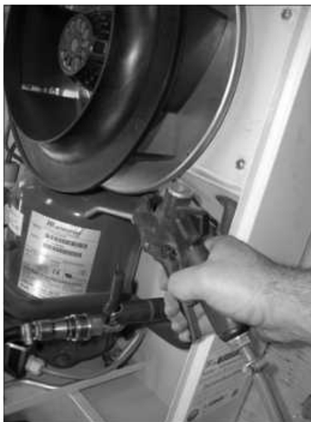
Abb. 80: Wärmetauschregister und Kompressorraum mit Druckluft ausblasen (3)
