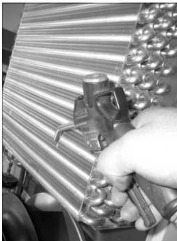
Abb. 79: Wärmetauschregister und Kompressorraum mit Druckluft ausblasen (2)
