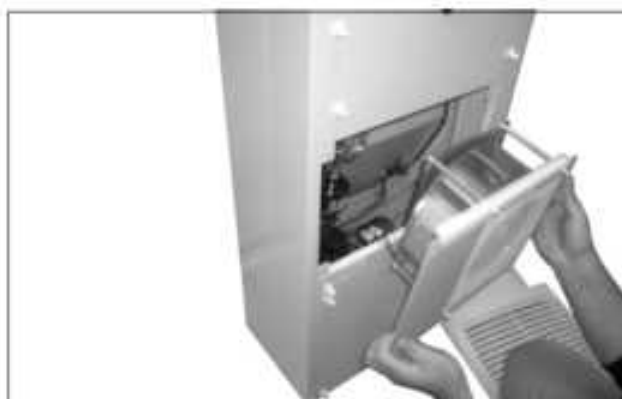
Abb. 68: Außenkreislauf Lüfter ausbauen
