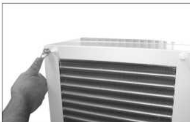
Abb. 48: Haube demontieren (vier Muttern lösen)
