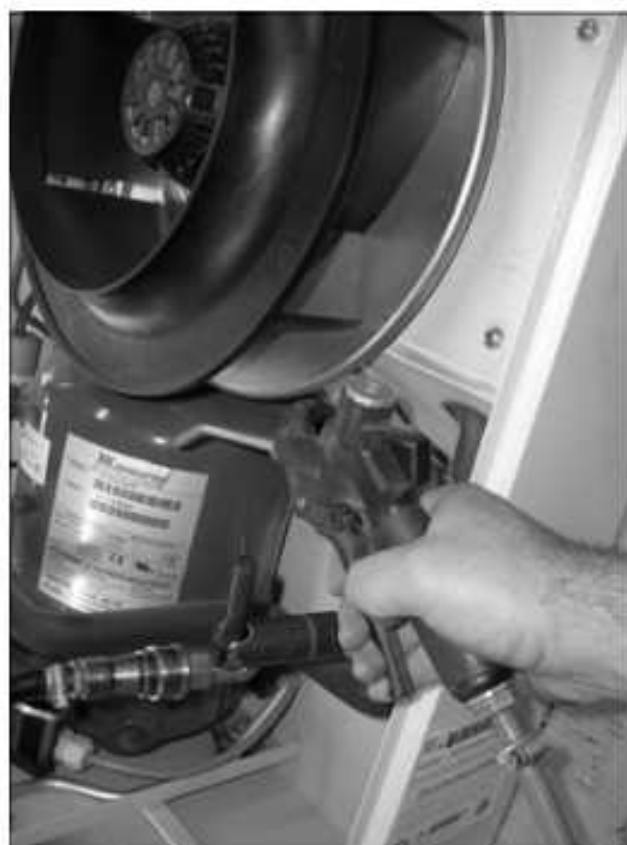
Abb. 56: Wärmetauscher und Kompressorraum mit Druckluft ausblasen (2)
